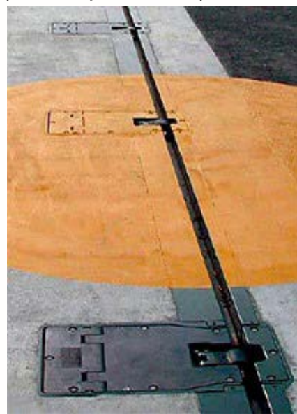
Рис. 18. Укладка приемного троса тормозной машины ВАК-14
