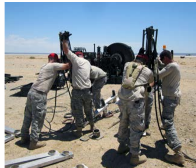
Рис. 6. Монтаж тормозной машины ВАК-12 в Ираке для Корпуса морской пехоты
